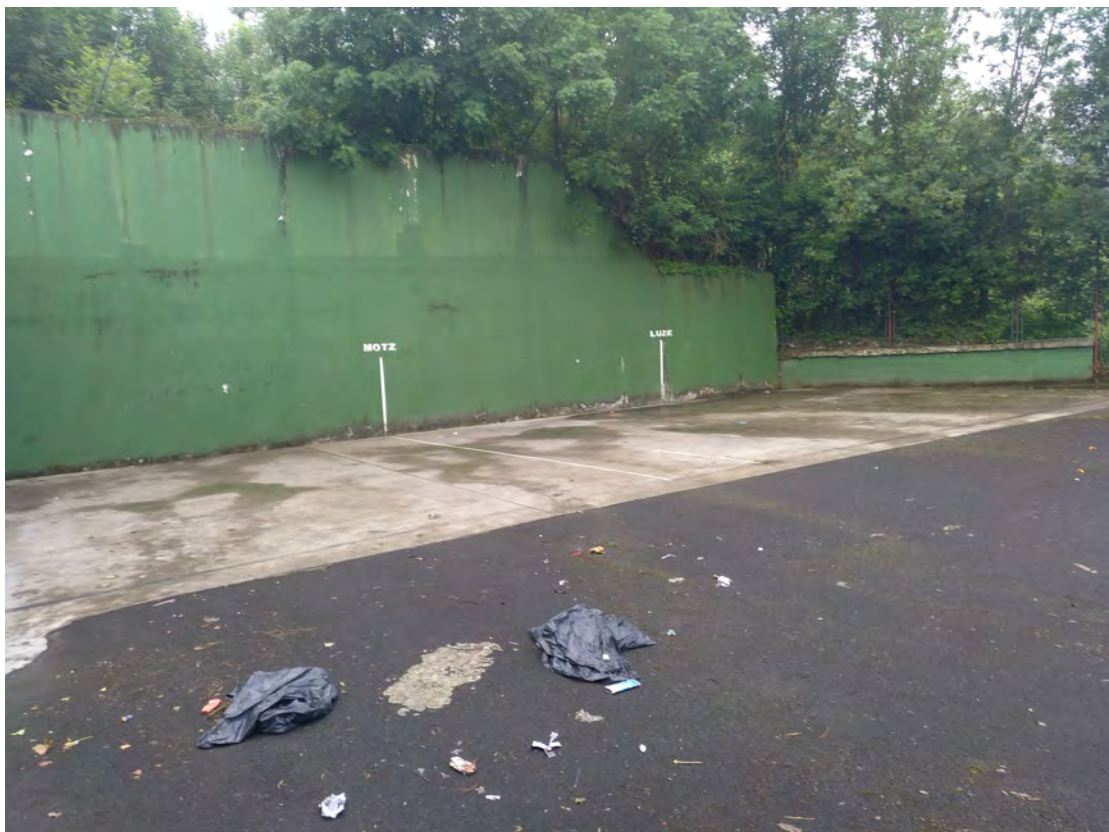
ESPACIO EXTERIOR: FRONTÓN
