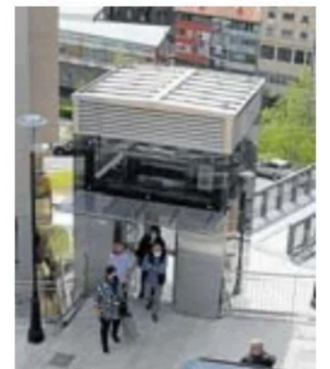
El ascensor afectado. J.L.
