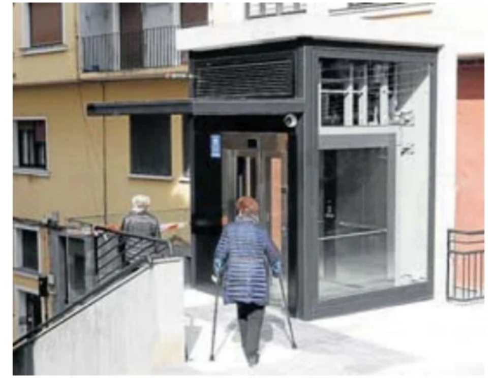
Dos mujeres, ayer, junto al acceso superior del nuevo ascensor. J. LEON
